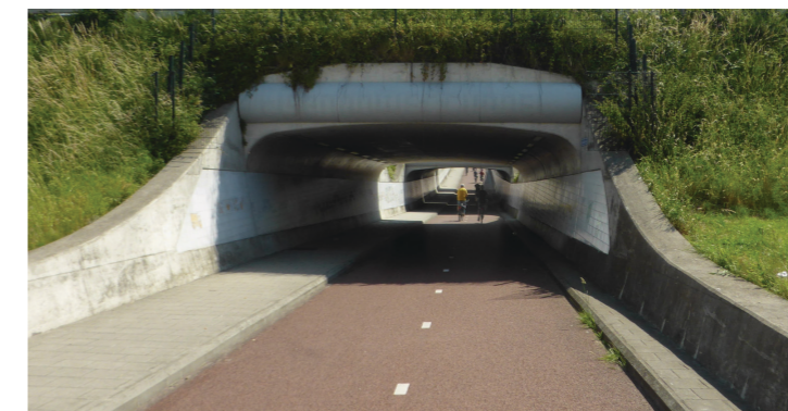
A hollandiai F325-ös kerékpáros sztrádán található Eisenhower alagút. Egyenes megközelíthetőség, jó beláthatóság, egyenletes kanyarok az alagút bejáratánál, és napfényablakok a képek [5]
