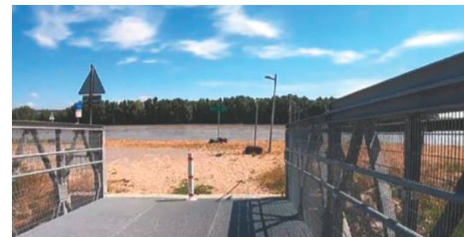
17. ábra: Cölöp a kerékpárút közepén az EuroVelo 6 ausztriai szakaszán
