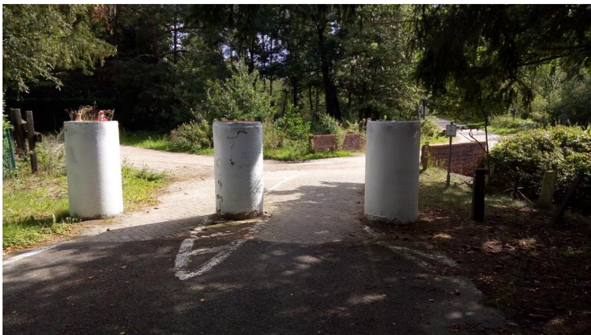
4. ábra: A távoli vidéki területeken a tipikus terelőszlopokat rendszerint megrongálják, ezért néha masszívabb konstrukciókat használnak az illetéktelen áthaladás megakadályozására.
