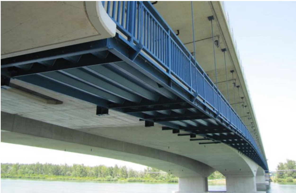
42. ábra: Kerékpárút az S33-as gyorsforgalmi híd alsó szintjén a Dunán átvélő hídon, Ausztria.
