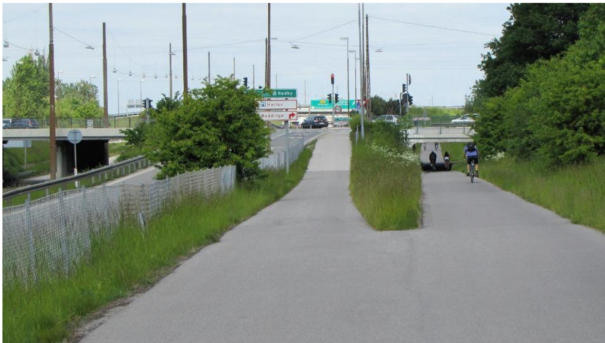
40. ábra: Az autópálya mentén futó kerékpárutak a csomópont kialakításába integrálva. Farum Route, Nagy-Koppenhága.
